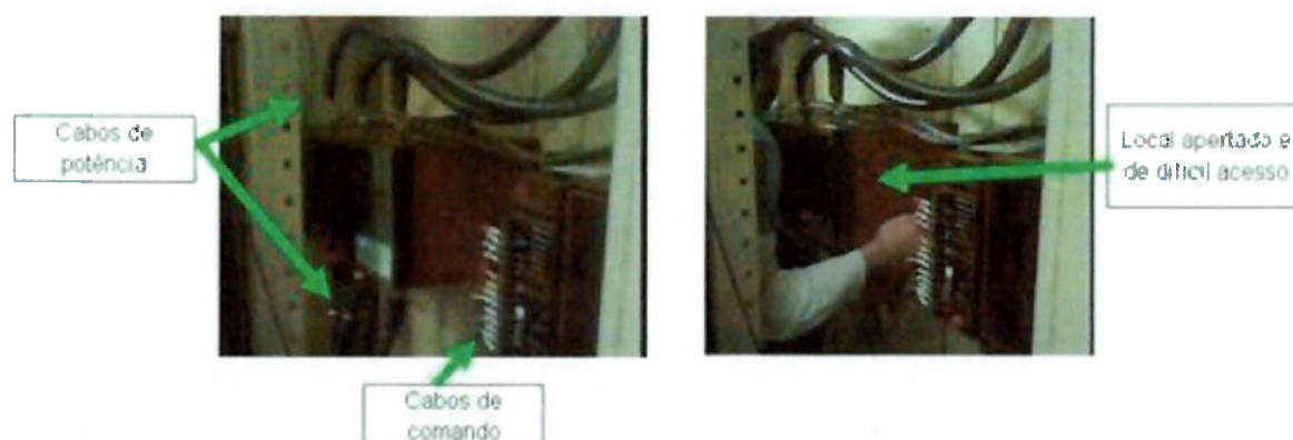
Figura 47 - Dificuldade para troca dos módulos de potência CPC.
