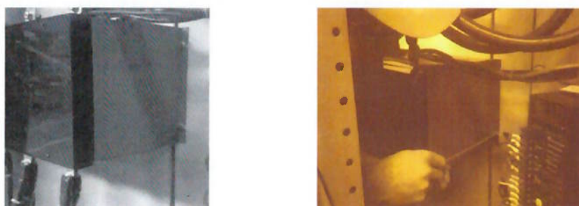
Figura 47 - Dificuldade para troca dos módulos de potência CPC.
