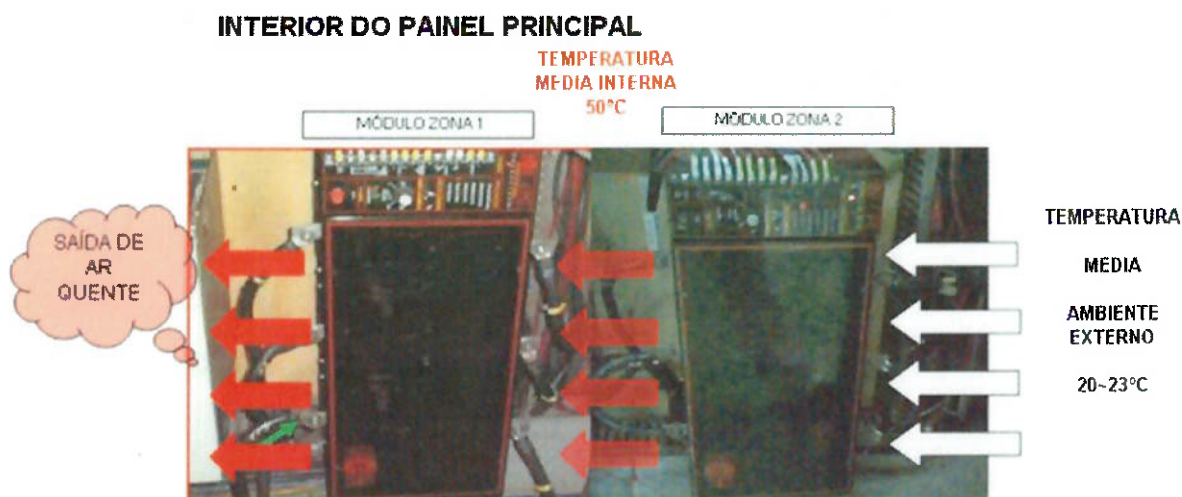
Figura 31 - Modo de instalação dos módulos de potência (relação de temperaturas e suas influências).
